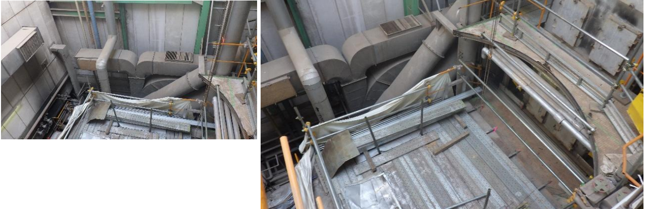
灰出しコンベア解体撤去（撤去中）
